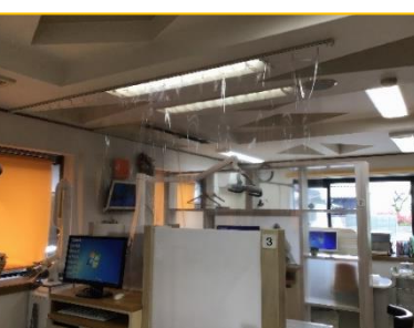
・間仕切りビニールスクリーンの設置(飛沫感染防止)
